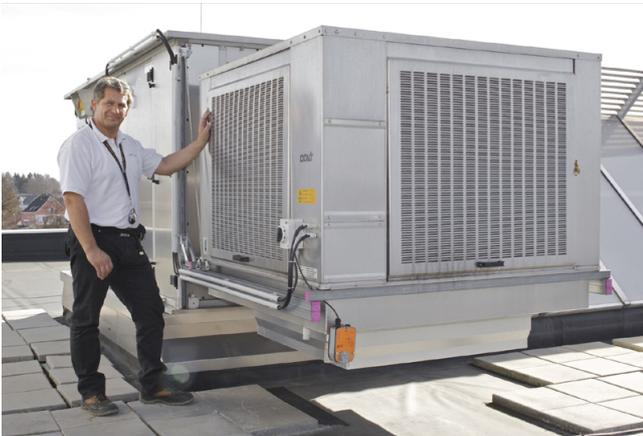
Udo Bär von der Gealan Formteile GmbH hat den Prototyp einer Klimaanlage auf Basis der adiabatischen Kühlung mit entwickelt. Sie sorgt in einer Produktionshalle für Spritzgussteile für angenehmes Arbeitsklima. Fotos: bgrci/Plöger
